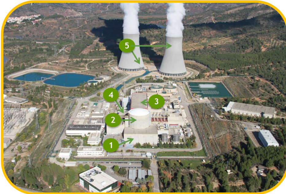
Figura 5. Edificios principales C.N. Cofrentes.
